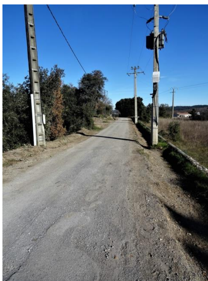
Suppression des deux poteaux et déplacement du transformateur au niveau du carrefour (patte d'oie)
