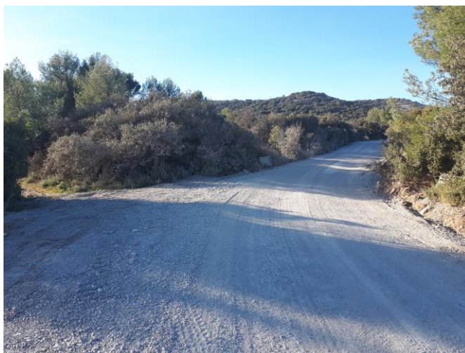
Chemin de la carrière, début de la partie privée. A gauche débouché du chemin de la Vialate depuis Corconne
