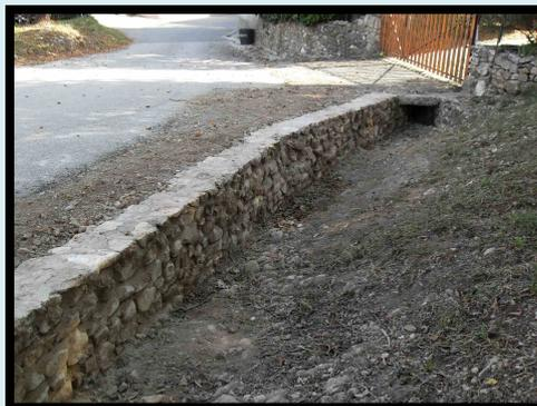
*Actuellement une entreprise spécialisée construit un mur de soutènement sur le côté droit. La circulation des véhicules sera ainsi grandement améliorée sur cette voie.*
